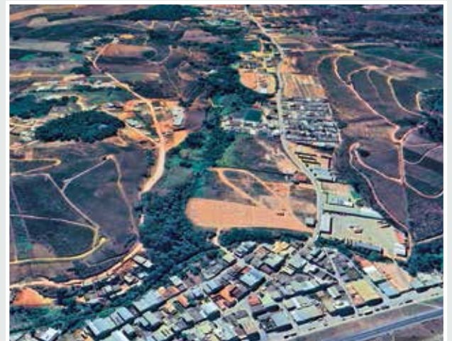
Vista da Av. Laurindo Alves Moreno, à direita
