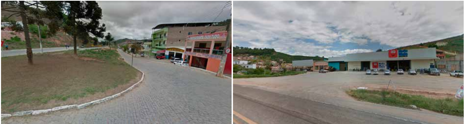
Pavimentação, drenagem e estacionamento na Avenida Afonso Cláudio e rede de água na Avenida Belo Horizonte são algumas das obras indicadas
